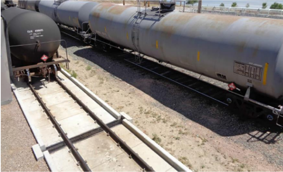
Figura 3-4: Vagones de transporte de graneles líquidos sin presurizar y elementos de contención típicos.
