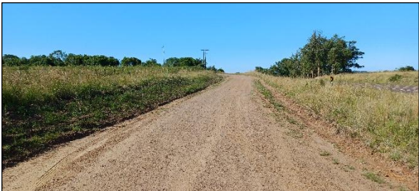
Ilustración 5-9 - Camino Cuchilla de Aguará Próximo a Ruta 5
