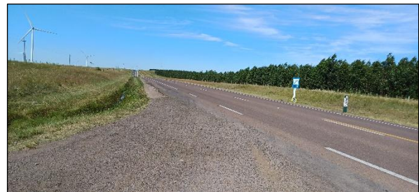
Ilustración 5-4 - Ruta 5 Km322 Altura del acceso a Piedra Sola
