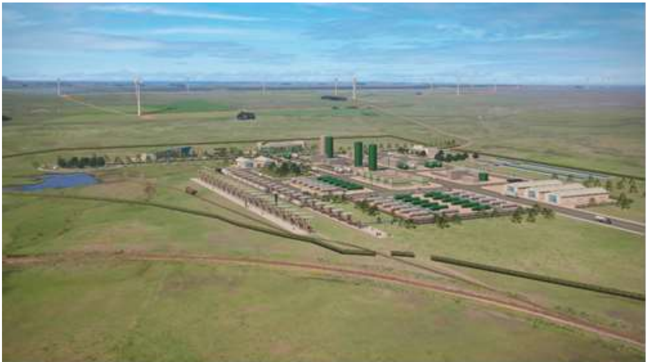
Fotomontaje de planta de producción (la imagen de las instalaciones no necesariamente coincide con el layout de la planta)
